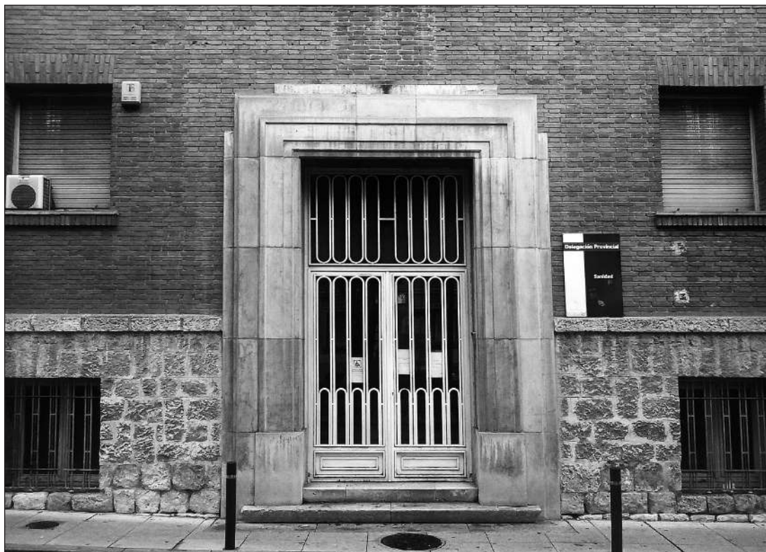
Fig. 6. Instituto Provincial de Higiene, puerta principal . Arquitecto: Aurelio Botella Enriquez, 1949. Fotografía de los autores, 2014. Colección particular.
