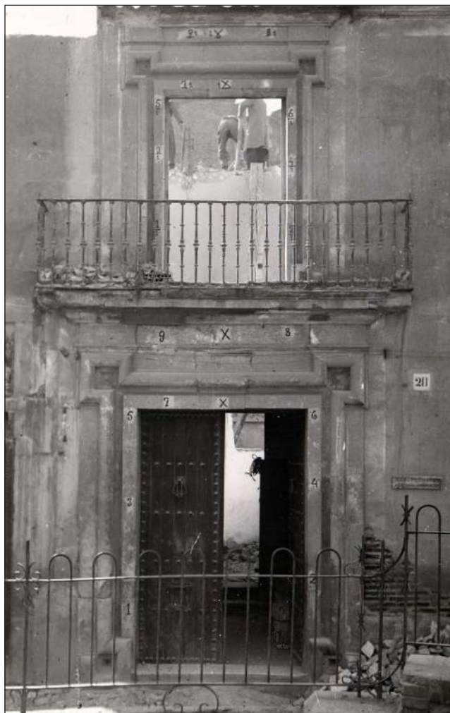
Fig. 11. Proceso de demolición del palacio de los Bedoya. Fotografía Andrada, 1948. Archivo Municipal de Guadalajara.
